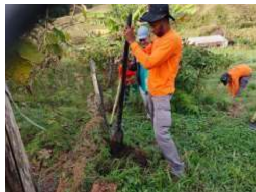
Fotografía 2 Labores de ahoyado.
